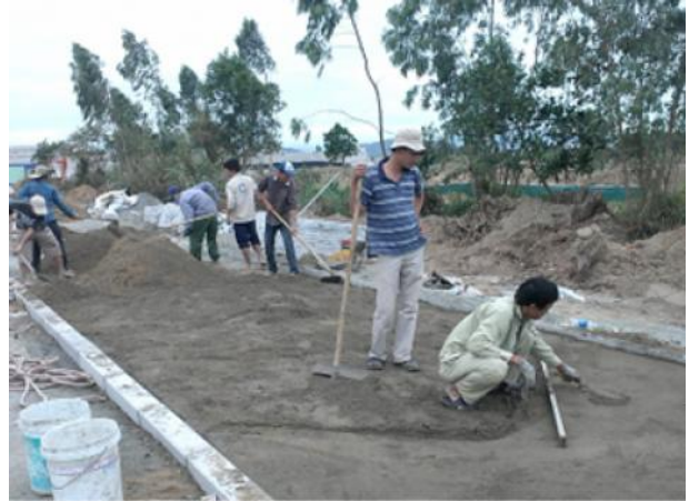
Thi công l p t bó v a và l p m v a
