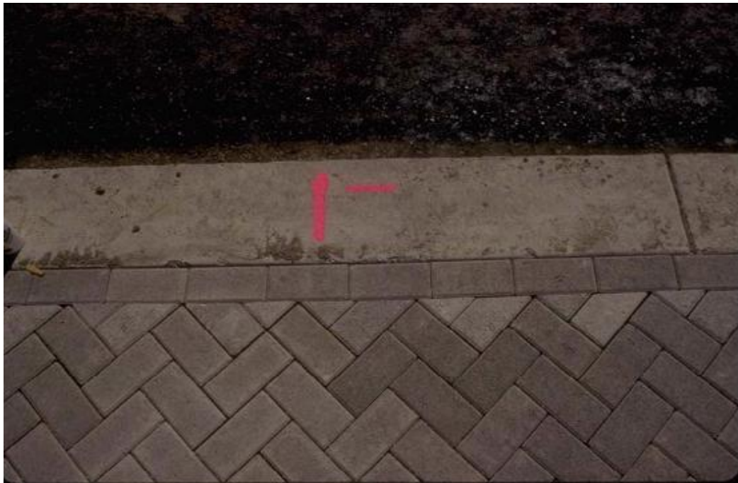
sát bó v a nên lát m t hàng g ch nguyên viên s d nhìn và t t h n v ch u l c
