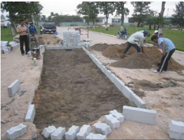
ào b BTXM h h ng, thi công á v a vi n xung quanh và làm l p m cát gia c xi m ng
