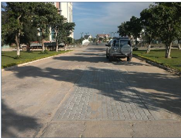
ào b BTXM h h ng, thi công á v a vi n xung quanh và làm l p m cát gia c xi m ng
