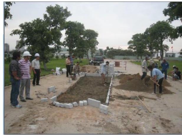
ào b BTXM h h ng, thi công á v a vi n xung quanh và làm l p m cát gia c xi m ng
