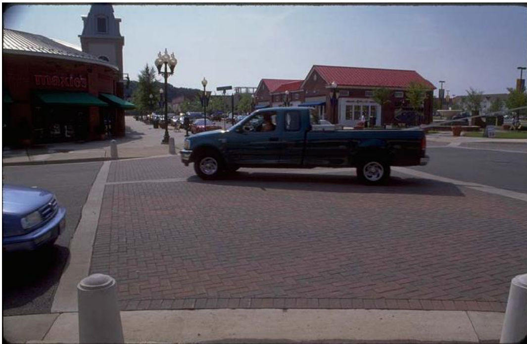
ng d ng lát g ch t chèn làm các l i cho b hành b ng ngang ng trong ô th
